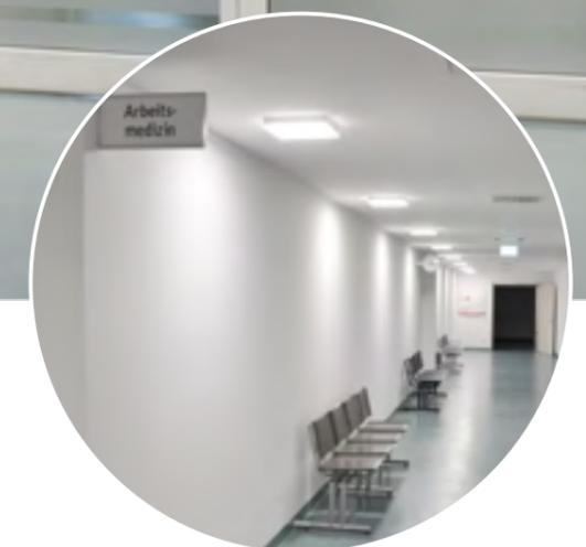
*Anbauleuchte Matri Flex (AMX) lässt sich einfach an die Decke anschrauben. Ihre „Schwester“ EMX verfügt als Einbauleuchte über ein intelligentes Befestigungssystem, das sich flexibel in jede Deckenöffnung einpasst. Ideal beim Leuchtaustausch, um bestehende Löcher einfach abzudecken (s. Seite 20/21).*
