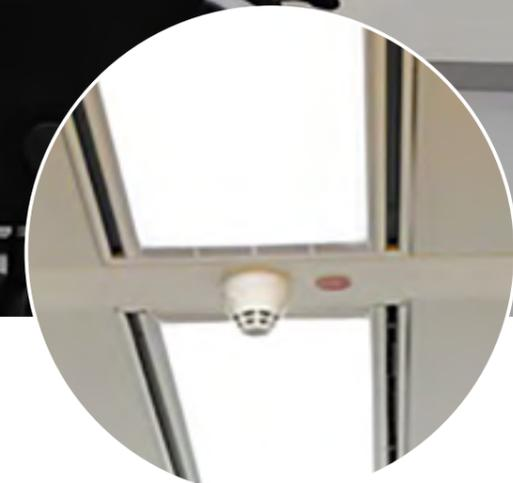
*AS LED Sonderleuchten mit Zu- und Abluft in den Alb-Fils-Kliniken. Die neuen maßgenauen LED-Leuchten wurden in die bestehenden Gehäuse der vorherigen konventionellen Beleuchtung gesetzt, die mit Klimatisierung gekoppelt waren. Das Deckensystem wurde nicht tangiert, die Installation erfolgte werkzeuglos und schmutzfrei.*
