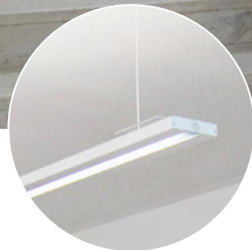
Pendelleuchte PIL in den Treppenhäusern des Klinikums Garmisch-Partenkirchen mit direktem und indirektem Lichtanteil. Sonderausführung mit zwei Netzteilen für AV/SV-Betrieb.
